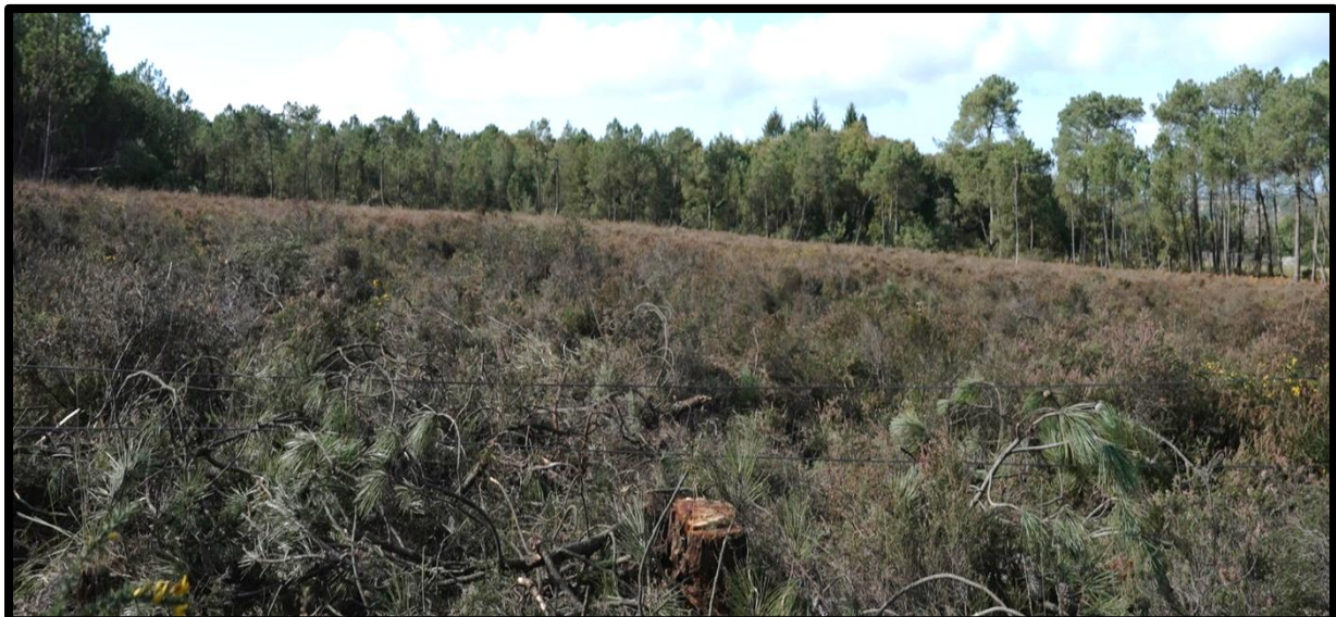
Photo du site après travaux :
