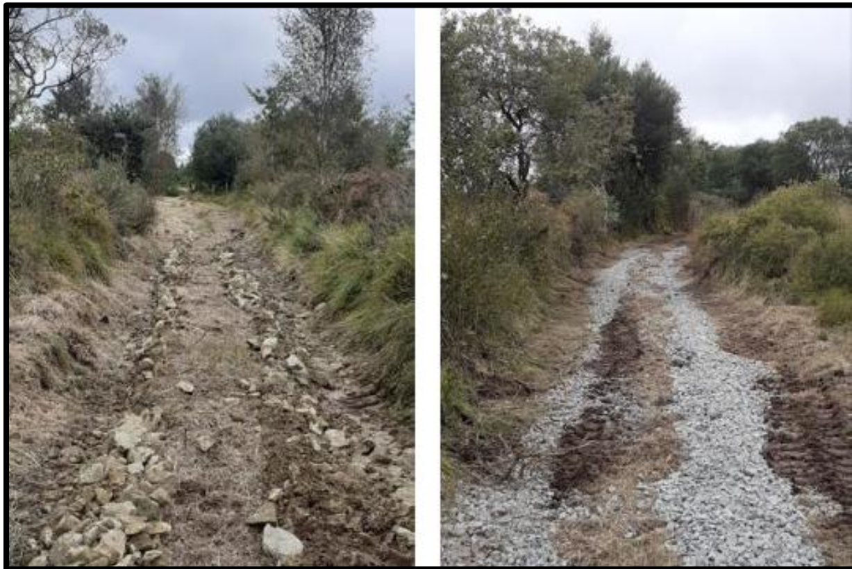
Photos du chemin du Venec pendant et après travaux
