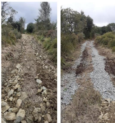
Figure 28 : Restauration d'un chemin agricole
