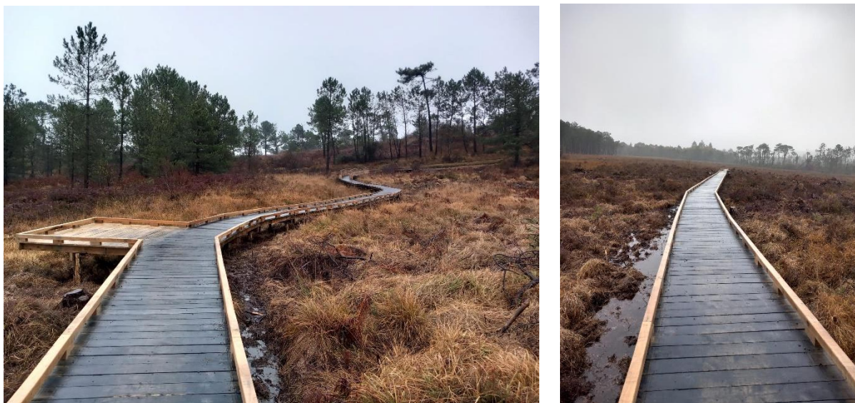
Figure 53 : Platelage bois sur la tourbière restaurée d'Argol
