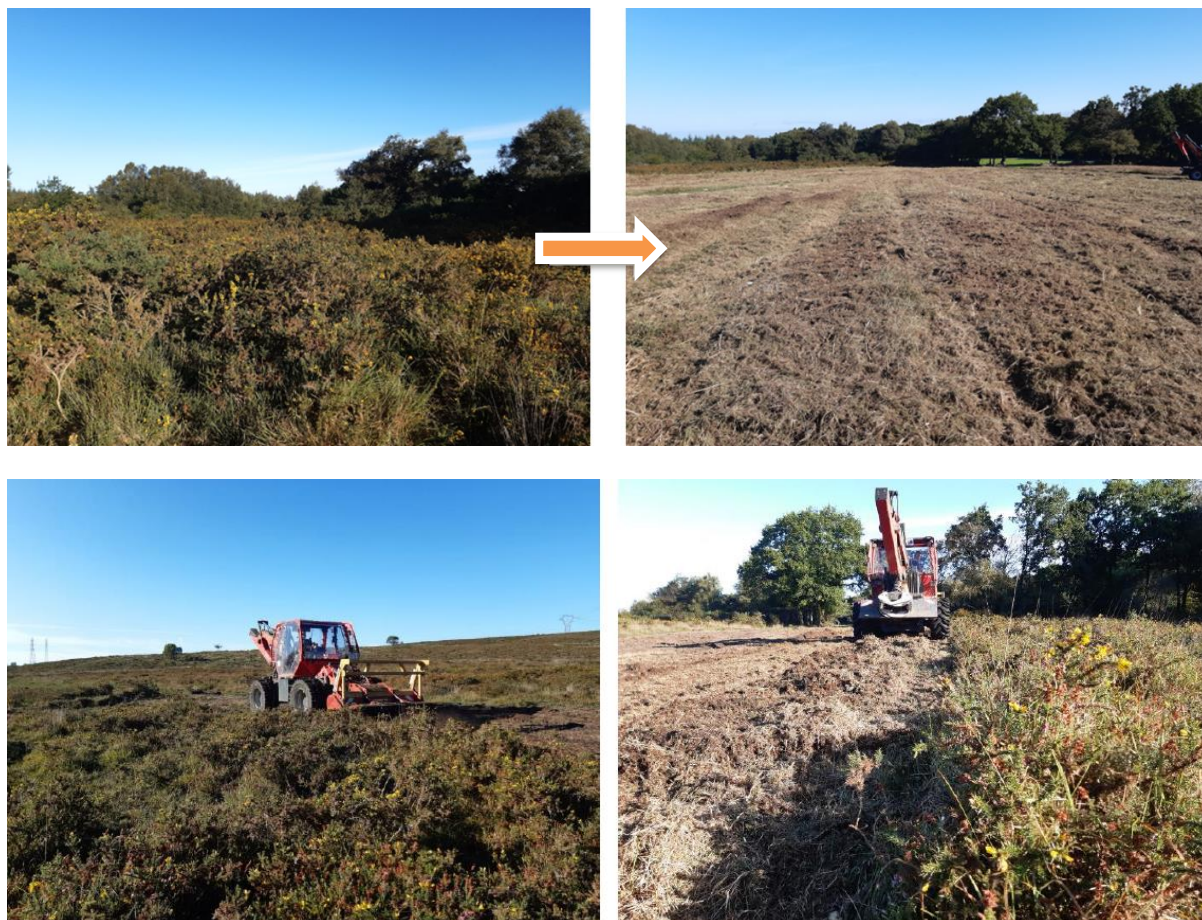
Figure 19 : travaux de réouverture de landes par broyage (Margily, Loqueffret)
