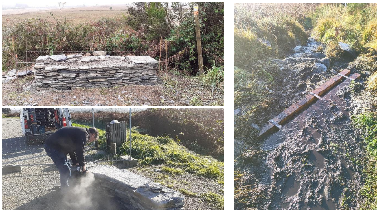
Figure 34 : Construction des murets d'interprétation ; Mise en place des bois d'eau
